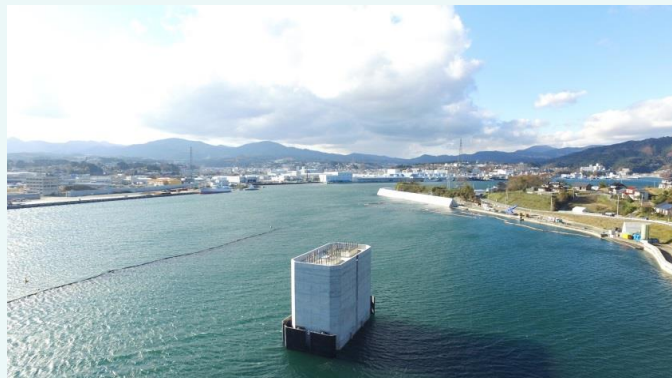
①P12橋脚完成狀況（空撮）
