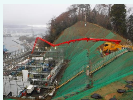
⑦コンクリート（1リフト）打設状況
