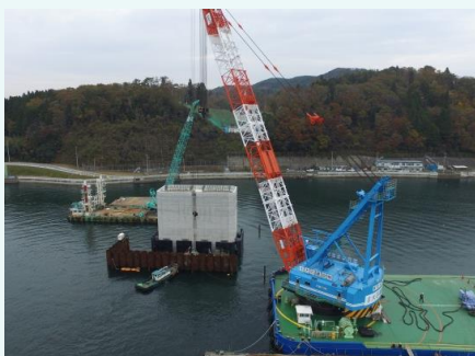
③鋼管矢板切断撤去状況
