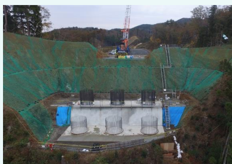
⑤深礎杭完了状況
