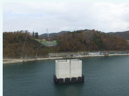
④鋼管矢板切斷撤去完了
