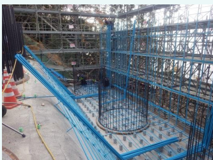
⑥鉄筋組立状況
