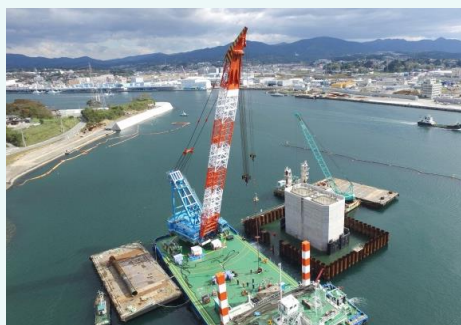
②鋼管矢板切断撤去状況
