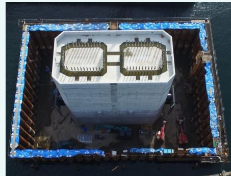
④トラス型支保工（1・2段）解体完了
