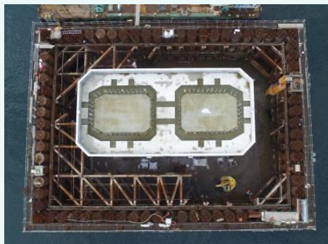
③トラス型支保工（１・２段）解体状況
