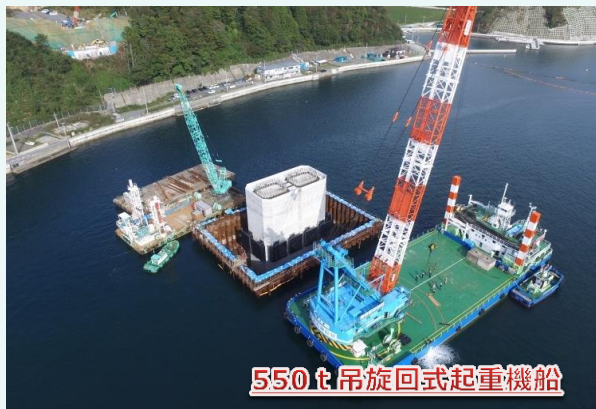
①防舷材設置状況（空撮）
