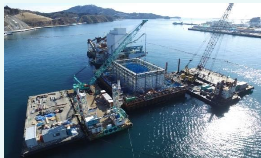
コンクリート打設状況（上空）
