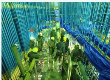
コンクリート打設状況（井筒内）
