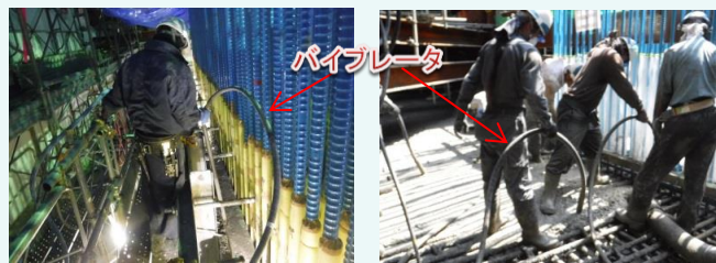
締固め状況写真
