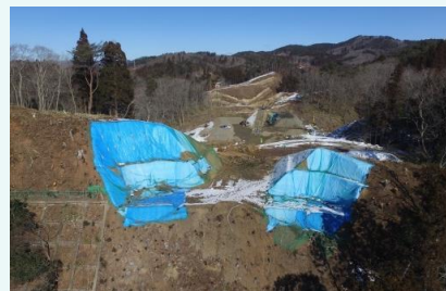
A2橋台現況
