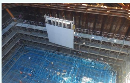
型枠建込状況
