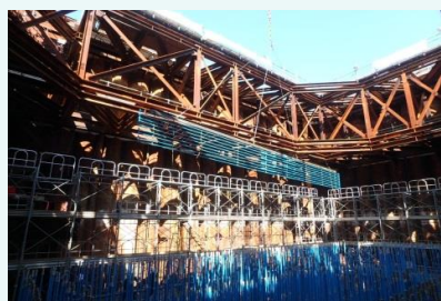
帯鉄筋組立状況
