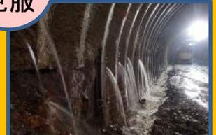
この地点まで掘削したところで大量の湧水が噴き出しました。量は最大毎分500トン。作業員は一時全員待避し、水量が減少するまで3日待ちました。その後、地山にセメントミルクを8日間にわたり注入し、湧水の量が毎分30トン程度に収まってから掘削工事を再開。〇〇トンネル全体の工事の中で、一番の難所でした。
