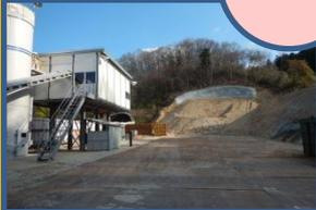
一番左の建物はトンネルのコンクリートに使う骨材(砂利)の製造プラント。トンネルの掘削により出てきた岩を、ここで砕き生コンと混ぜて、トンネルの壁面に使うコンクリートの材料にするのです。いわば、現場で発生した材料の再利用工場。その横にある建物の下に見えているのがトンネルの坑口です。
