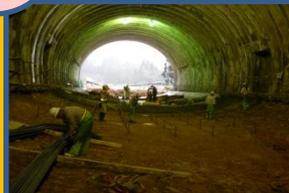
トンネルの下側に、地山からの圧力に対抗できる鉄筋コンクリート構造を巻き立てた部分(インバート)を施工している模様です。このトンネルは強固な地質だったため、インバートの施工は東西両側の坑口近くの100mづつだけで済みました。写真手前の方は鉄筋を組んでいるところ。奥の方には完成したインバートも見えます。
